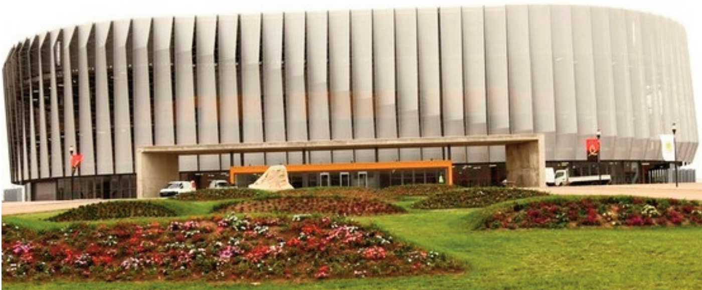
Arena Kilamba de Luanda (Angola) vue de l'extérieur
